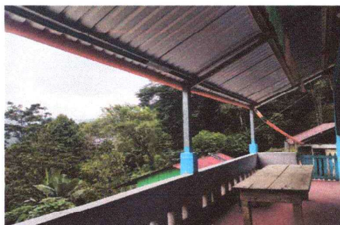
Foto 4: Estructura frontal del aula y colocación de canales.
