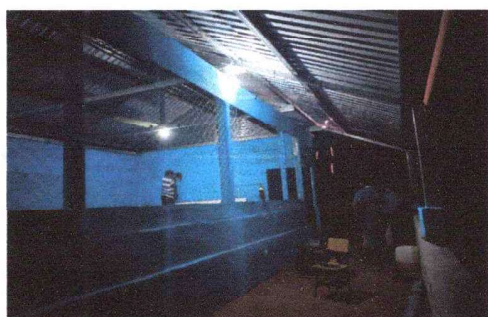
Foto 3: Finalización de reparación de sistema eléctrico.
