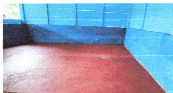
Foto 2: Resultado del mejoramiento del piso del aula.
