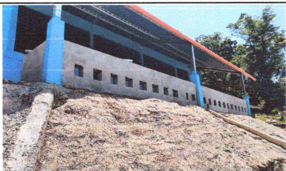
Foto1: Finalización de construcción de muro de contención.
